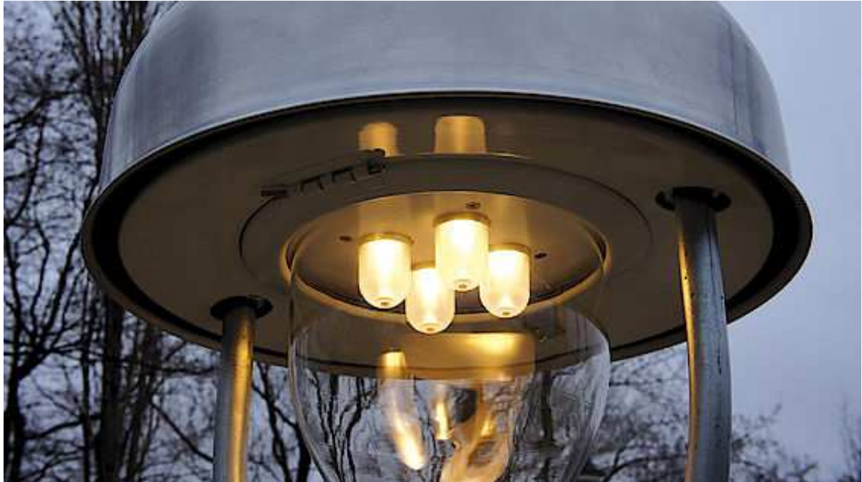
Auf LED-Leuchtmittel umgerüstete Gaslichtleuchte
